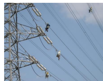
送電線工事作業風景
