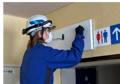
内線工事作業風景
