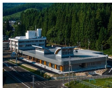
湯沢市皆瀬庁舎建築工事(電気設備)
