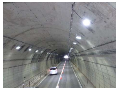
トンネル照明改修工事
