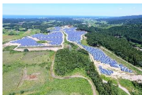
仁賀保太陽光発電所
