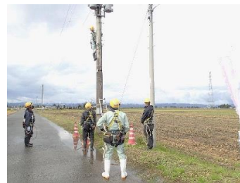
引込線工事のフルハーネスを着用しての昇降訓練
